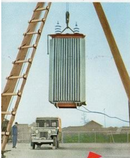
2トン半の重量物を上げるウインチ
